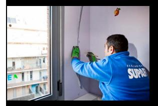
Replanteo de perforaciones en el muro, que garantizará la óptima distribución y el correcto insuflado del producto.
