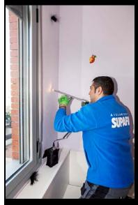
En los orificios efectuados se insertará la boquilla de la manguera que forma parte de la máquina de inyección,a través de la cual se insuflará la Lana Mineral Supafil 034, rellenando toda la cavidad.
